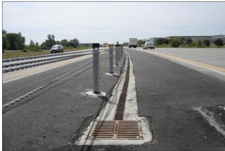
Figura 7: Ejemplo de Sumidero en el Separador Central
