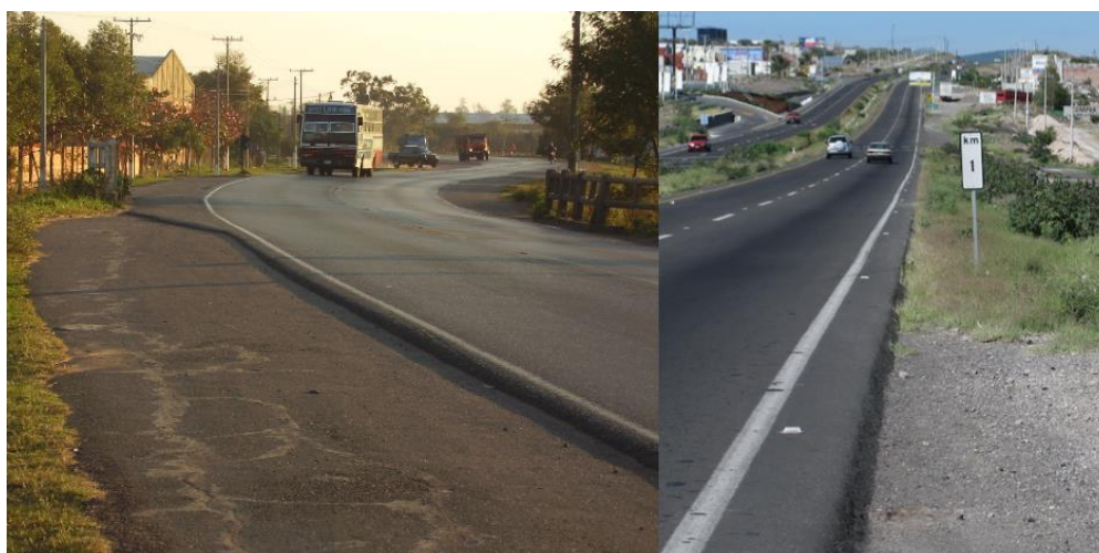
Figura 27: Ejemplo de Desniveles por Recapado
