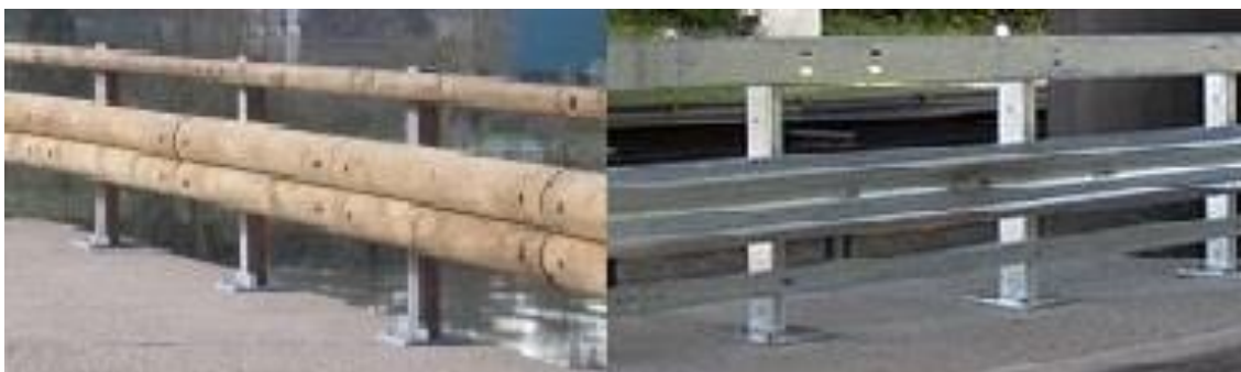
Figura 4: Ejemplo de barreras rígidas
