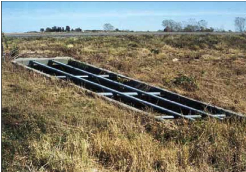
Figura 14: Ejemplo de Tratamiento Seguro de Alcantarillas Transversales
