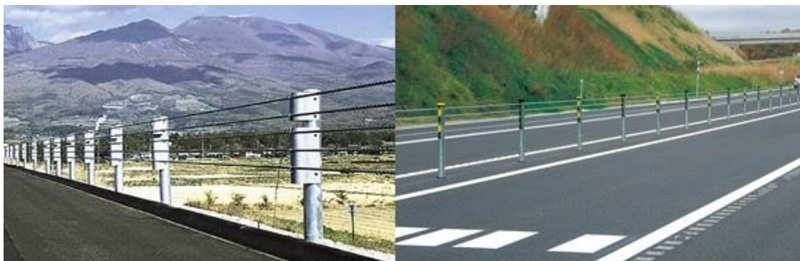
Figura 2: Ejemplo de barreras flexibles
